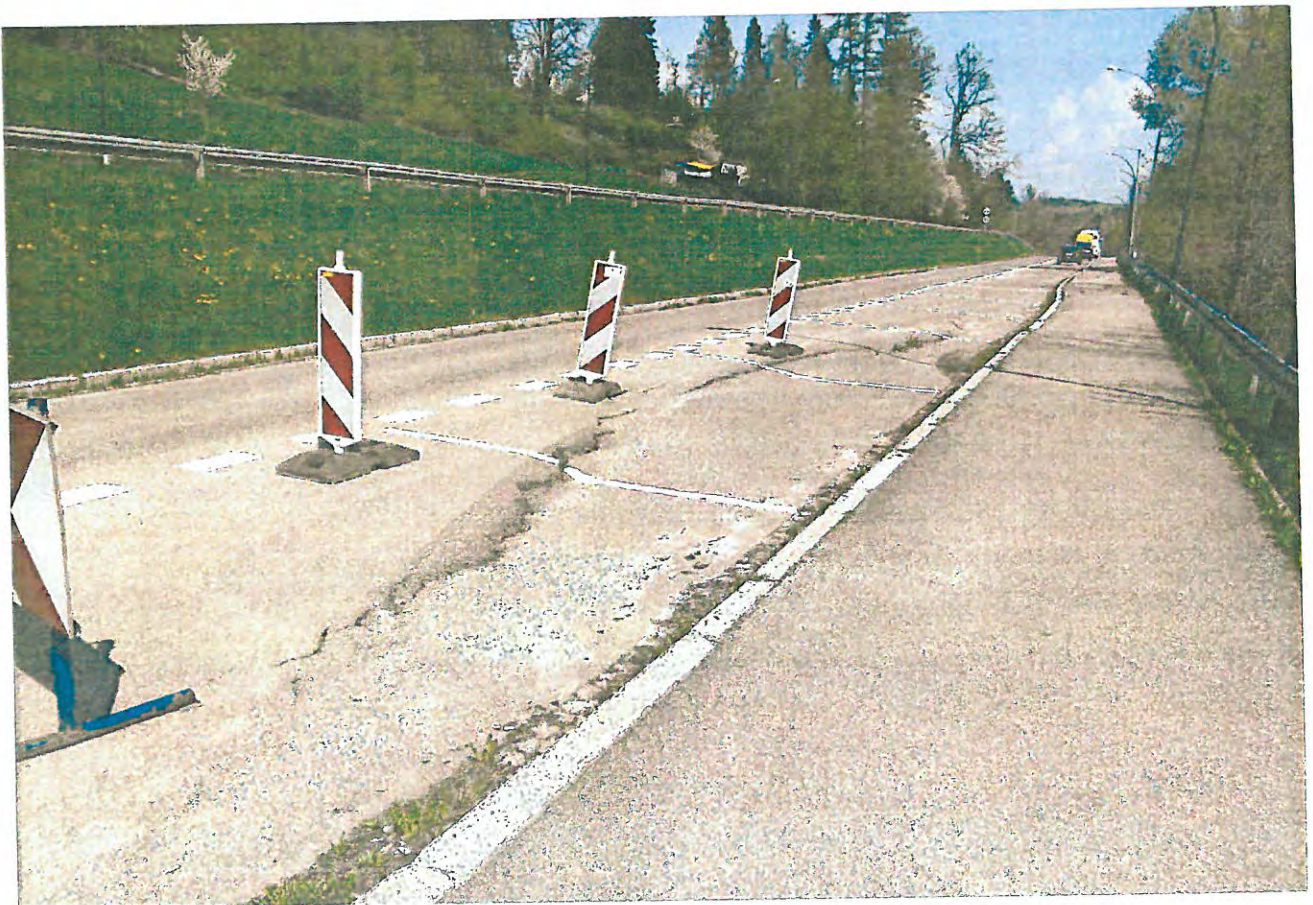
Fot. 5 – Spękania i deformacje w obrębie drogi powiatowej (skarpa główna).
