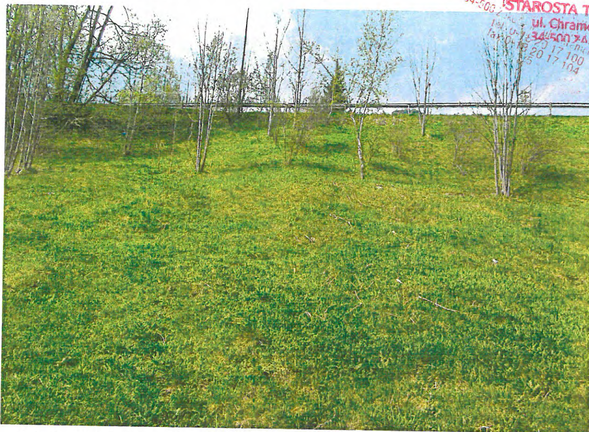
Fot. 6 – Widok na osuwisko od strony zachodniej.
